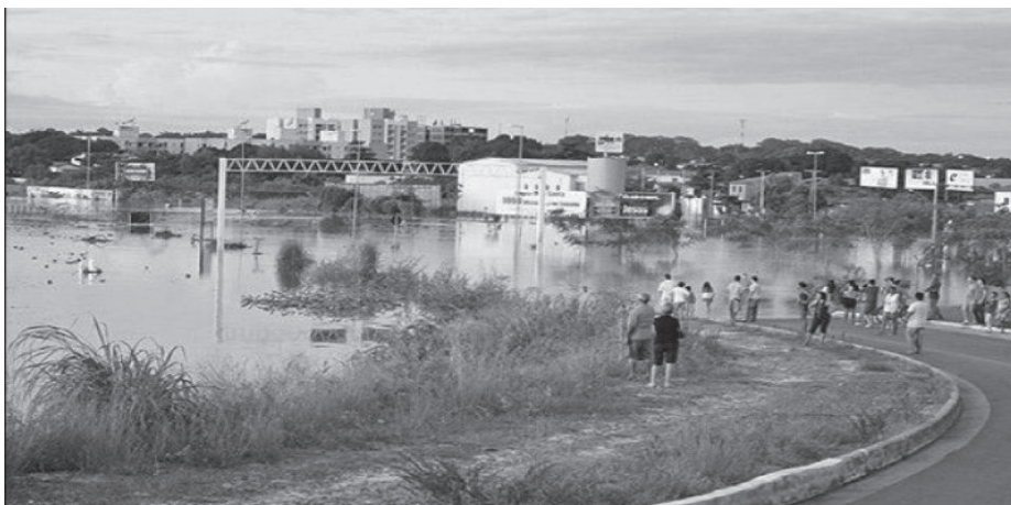
Figura 8 - Ponte Wall Ferraz interditada, Bairro dos noivos, zona Leste de Teresina (2009).
