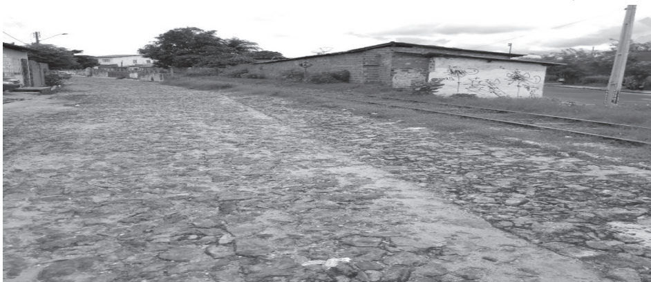
Figura 6 - Proximidade dos trilhos a residências, sem nenhuma proteção.
