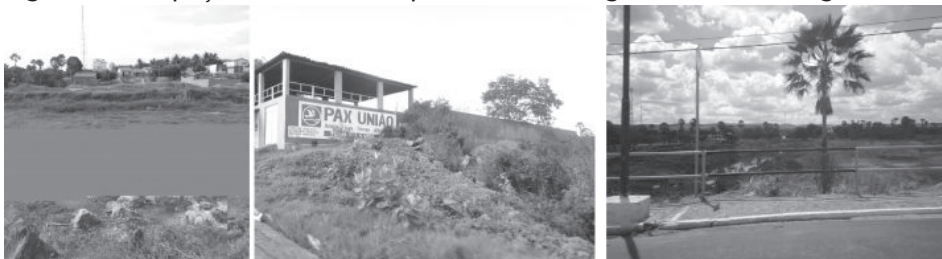
Figura 2 - Ocupação desordenada próximos às margens do rio São Miguel
