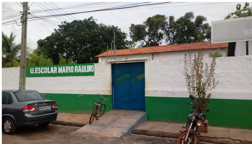
Foto 1 – Fachada da Unidade Escola Mario Raulino.
