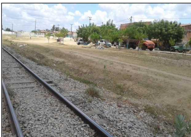
Figura 4 – Local onde existia a Estação Ferroviária
