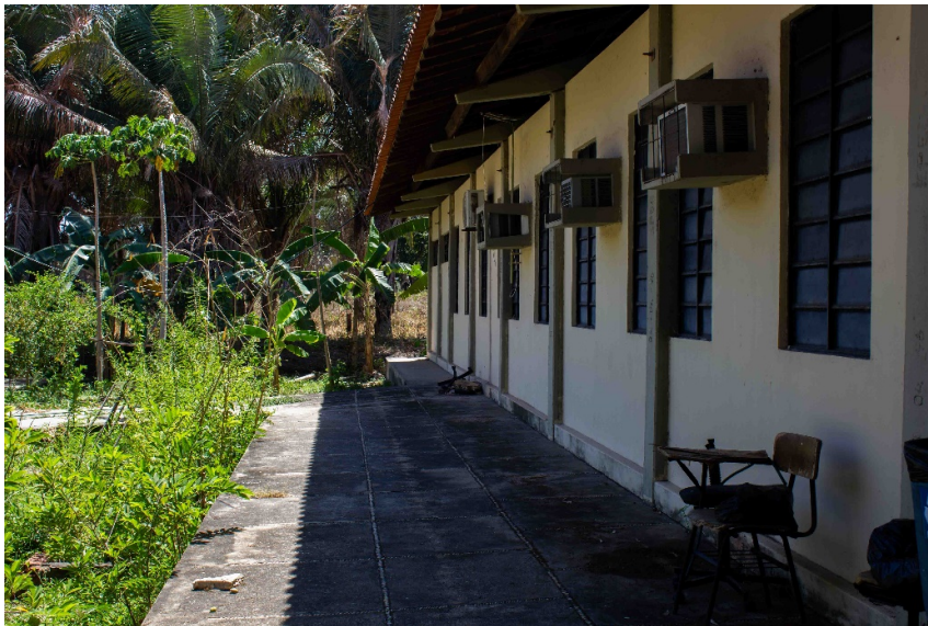
Foto 23 – Vista Lateral (Fundos) do Prédio onde está localizada a INEAGRO
