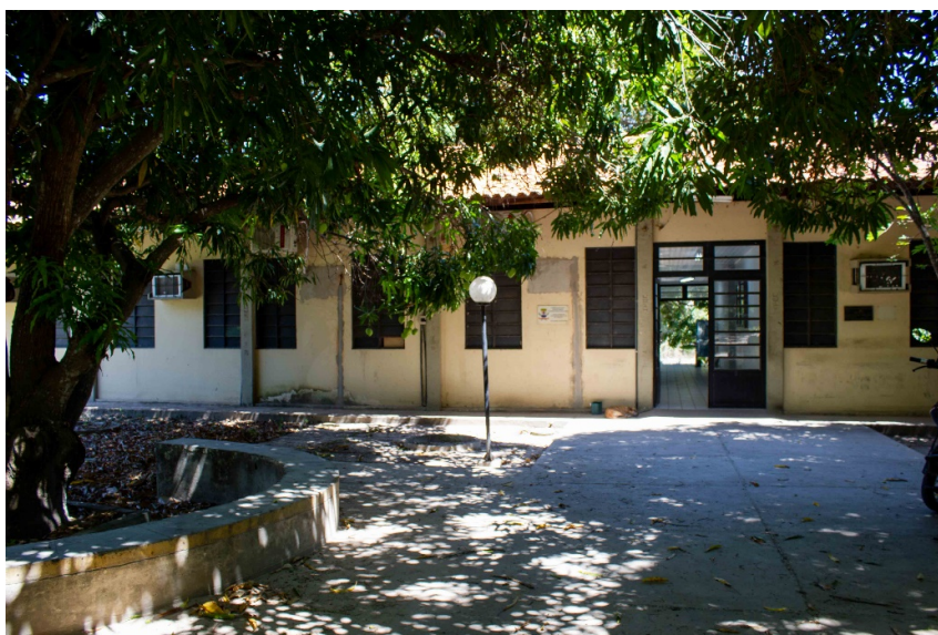
Foto 16 – Vista Entrada do Prédio onde está localizada a INEAGRO
