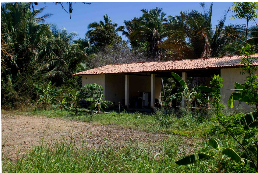
Foto 22 – Vista Fundos do Prédio onde está localizada a INEAGRO
