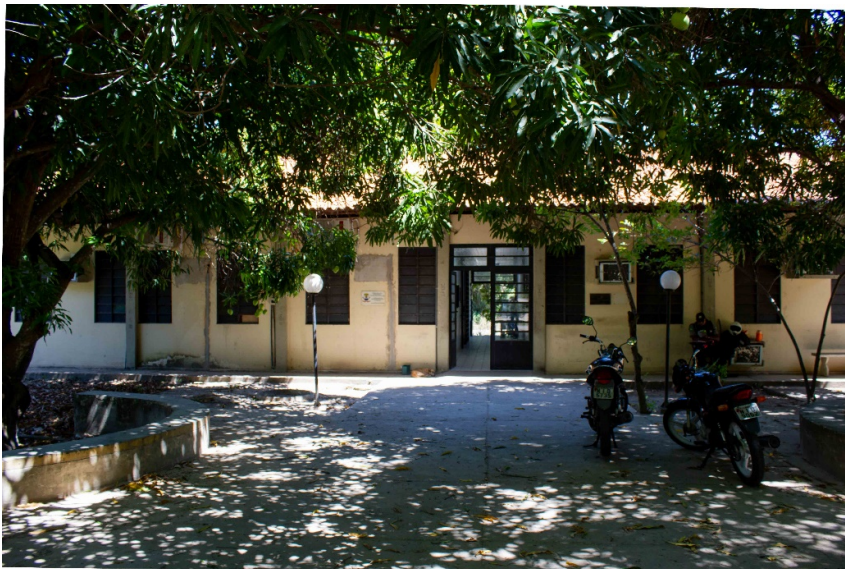
Foto 17 – Vista Entrada do Prédio onde está localizada a INEAGRO
