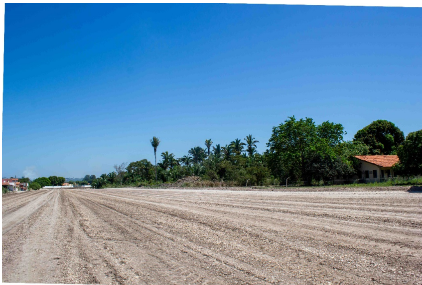
Foto 28 – Vista Avenida em Construção em frente ao Prédio onde está localizada a INEAGRO
