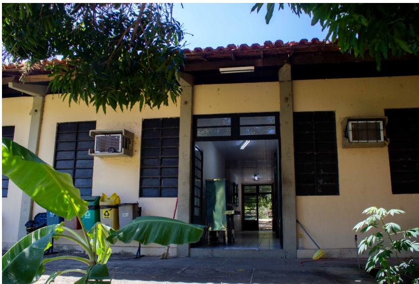
Foto 24 – Vista Saída (Fundos) do Prédio onde está localizada a INEAGRO
