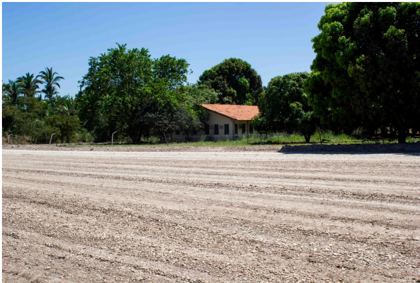
Foto 27 – Vista Avenida em Construção em frente ao Prédio onde está localizada a INEAGRO
