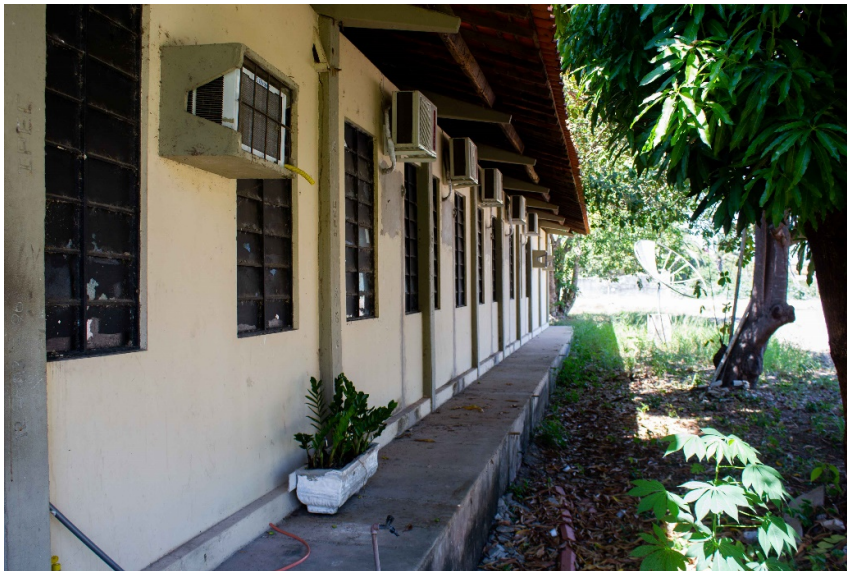
Foto 21 – Vista Lateral (Fundos) do Prédio onde está localizada a INEAGRO
