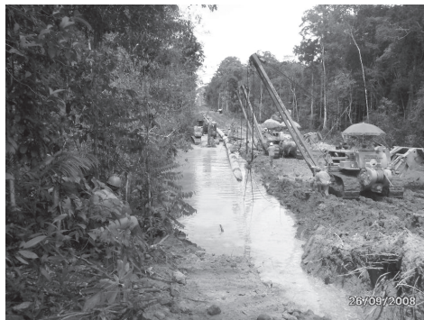
Figura 15: Atividade de campo para a construção de oleoduto.
