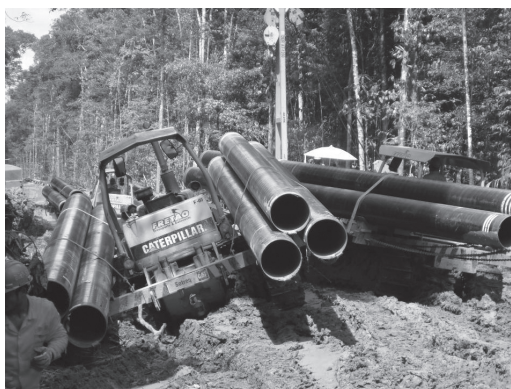
Figura 16: Tubos do oleoduto a ser construído.
