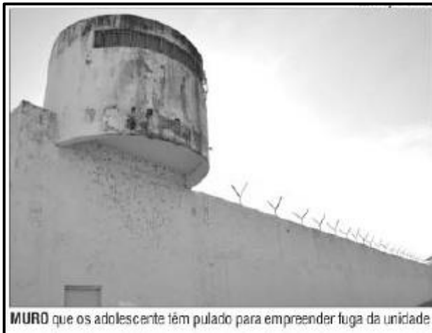
FIGURA 5 - Muro do Centro Educacional Masculino (CEM)
