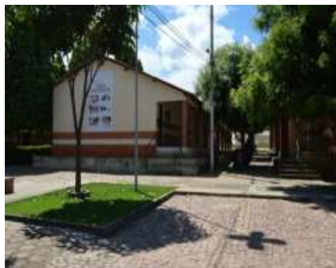
Figura 18 – Prédio do CTBJ
