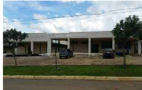
Figura 12 – Fachada do HVU-CPCE
