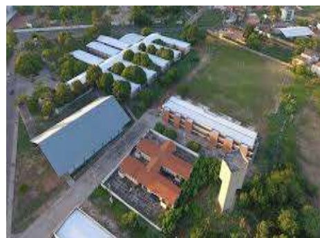
Figura 17 – Vista de cima do CTF
