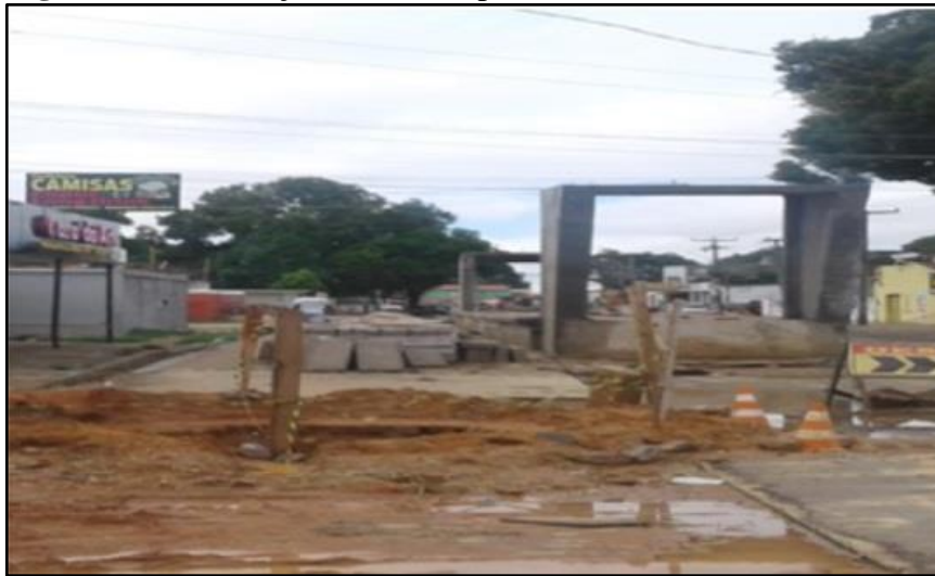
Figura 4 – Construção das novas paradas, avenida Rui Barbosa
