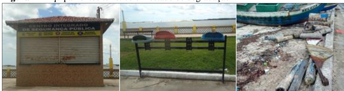
Figura 2 – Equipamentos turístico em estado de degradação
