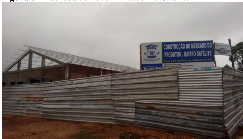
Figura 8 – Fachada do novo Mercado Do Satélite
