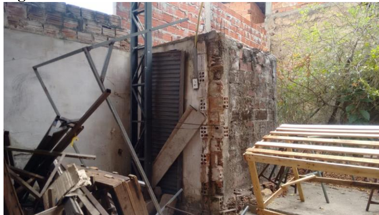
Figura 5 – Banheiro desativado da sede 2
