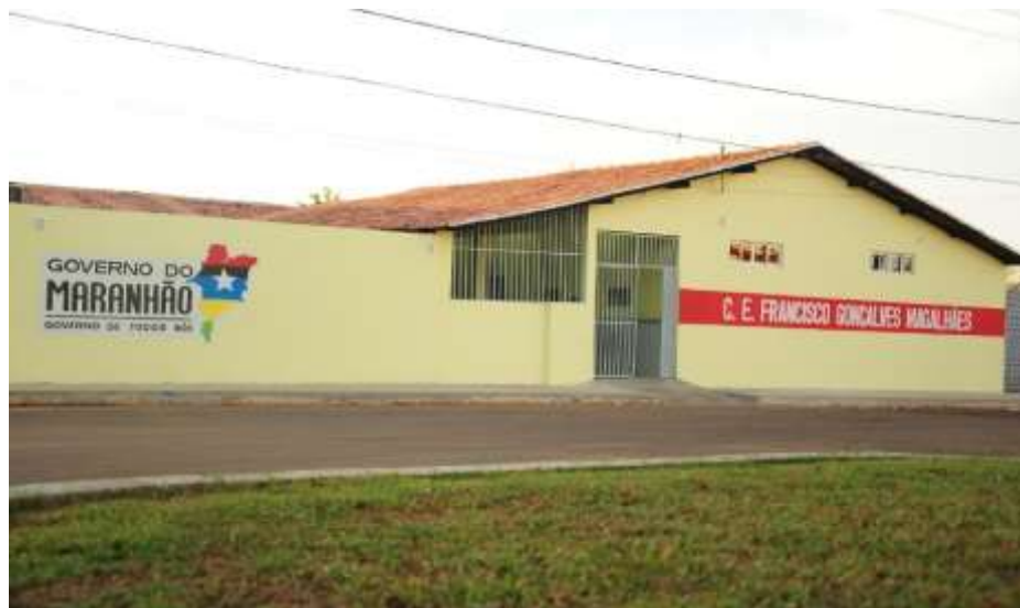
Foto 3 - Centro de Ensino Francisco Gonçalves Magalhães. Vista da fachada.
