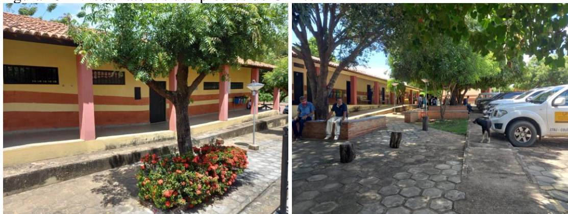
Figura 25 - Vistas laterais dos prédios do CTBJ.
