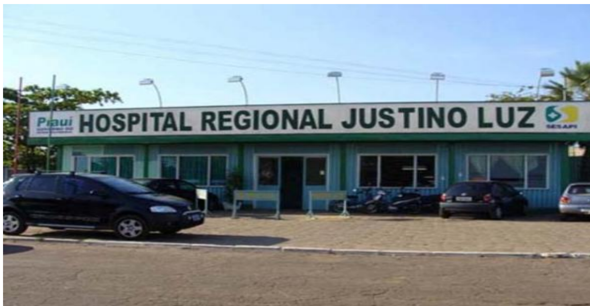
Fotografia 6: Vista frontal do Hospital Regional de Picos
