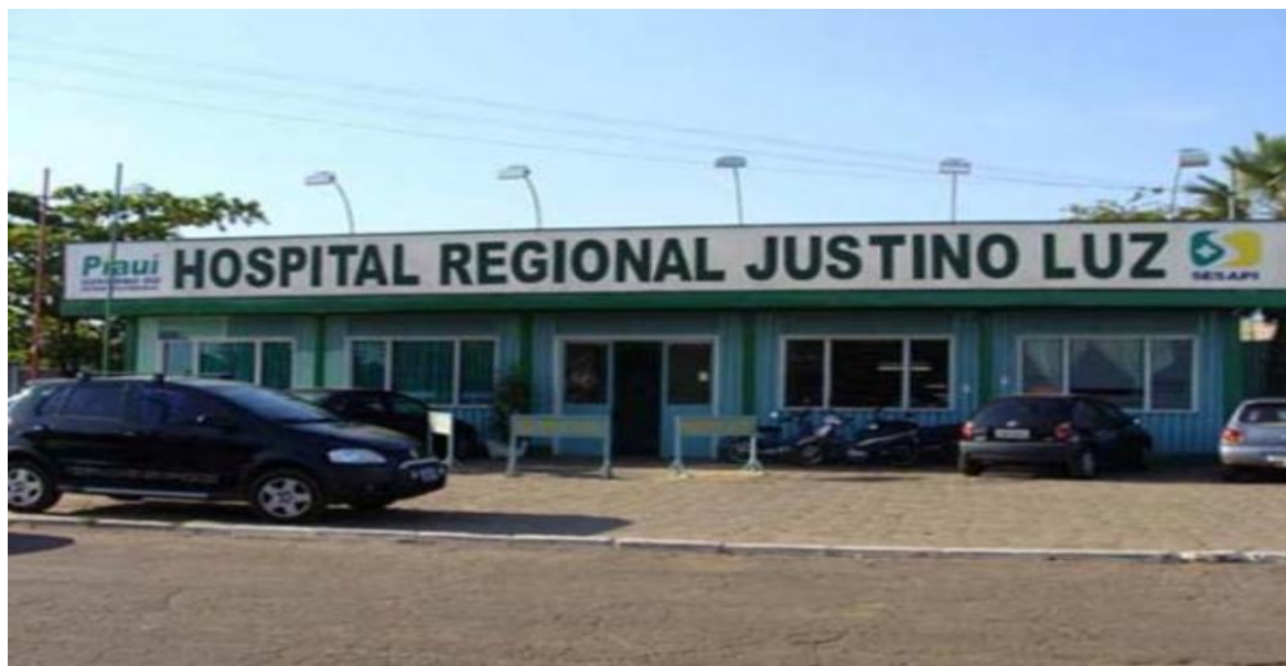
Fotografia 6: Vista frontal do Hospital Regional de Picos
