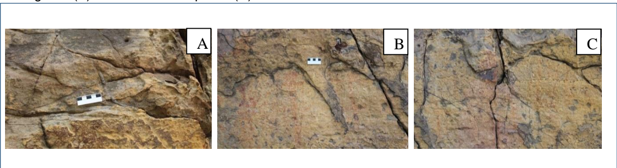
Figuras 2 – Identificação dos problemas de conservação do sítio Pedra do Letreiro. (A) Problemas Biológicos. (B) Problemas Antrópicos. (C) Problemas Físico-Químicos.
