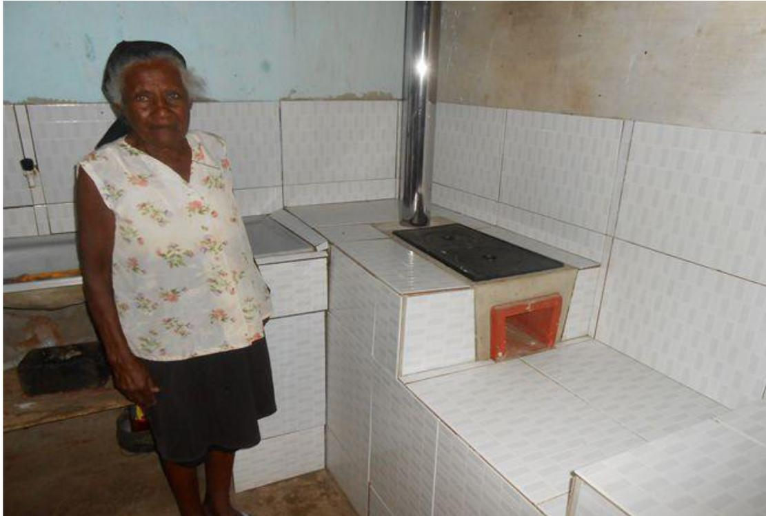
Figura 71 - Fogão Ecoeficiente ou Ecofogão. Fonte: Ecofogão, novembro de 2017. Disponível em: <https://ecofogao.com/ecofogao-do-bem/>
