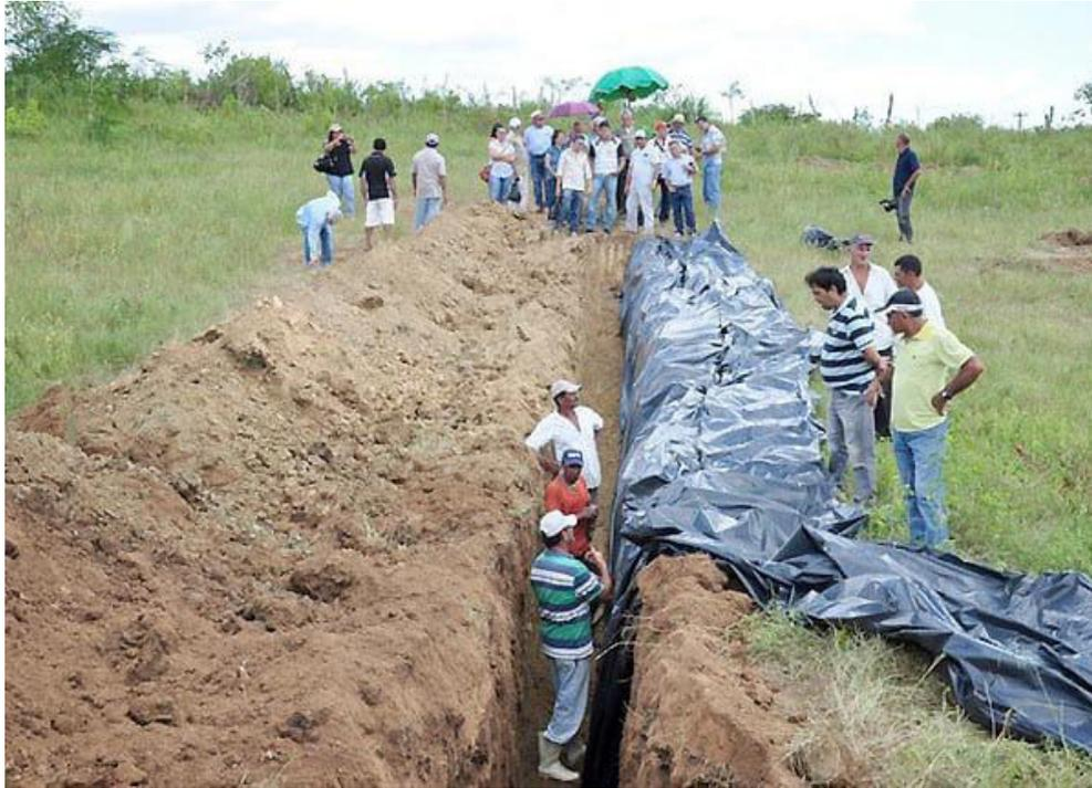
Figura 55 - Barragem subterrânea. Fonte: Integração Babia, março de 2015. Disponível em: <https://www.integracao-babia.com.br/v1/2015/03/28/barragem-subterranea-dribla-a-seca-e-da-sustentabilidade-a-agricultura-familiar/>
