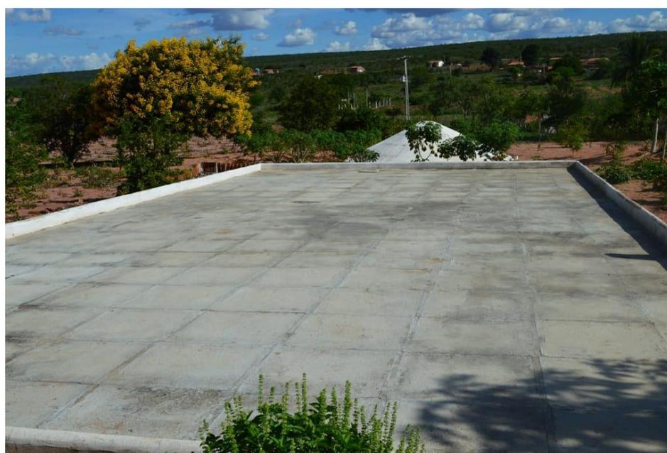
Figura 50 - Cisterna calçadão de 52 mil litros. Fonte: Coopagel, setembro de 2016. Disponível em: <https://www.assisra-malho.com.br/2016/09/construcoes-de-cisternas-calcaado-na.html?m=1>
