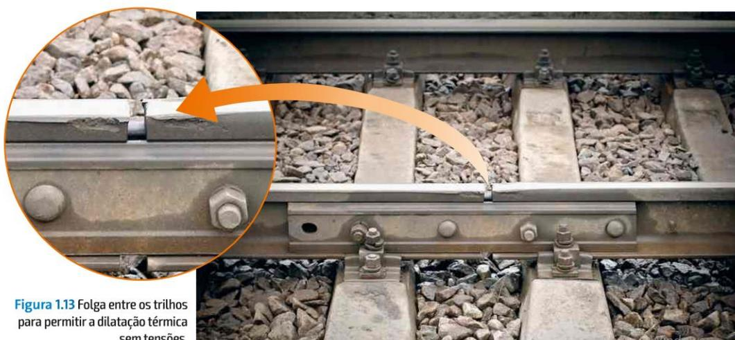
**Figura 1.13** Folga entre os trilhos para permitir a dilatação térmica sem tensões.
