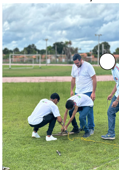
Foto 12 - Momento da fixação da base
